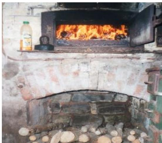
**Le four fut construit en 1910 et maçonné en briques rouges. Il a une dimension extérieure de 2m80 de long sur 2m50 de large. L'intérieur est en briques spéciales pouvant supporter une très forte chaleur. Il était chauffé uniquement au bois.**
